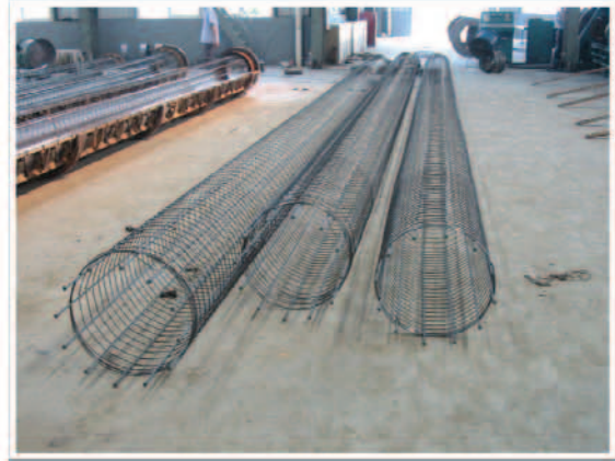
照片2 鋼筋籠製作
