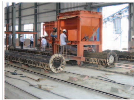
照片6 混凝土投料
