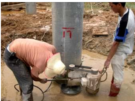
照片17 設計面以上PC樁切割
