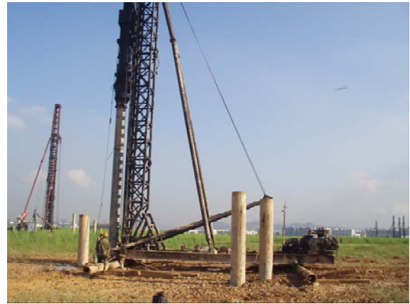
照片10 PC樁打設
