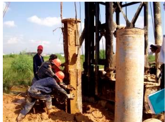
照片12 引樁筒引樁(或稱送樁)
