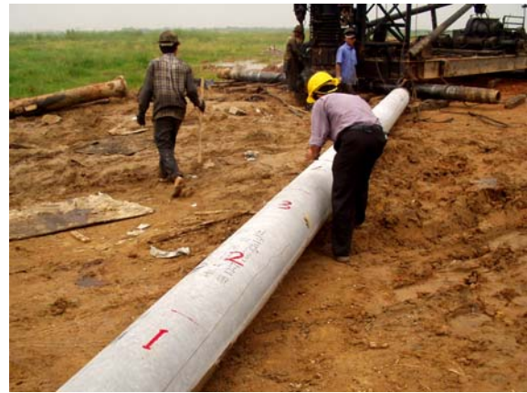
照片2 PC樁樁體檢查及長度標示刻劃
