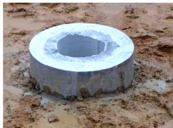
照片18 切樁完成樁頂狀況
