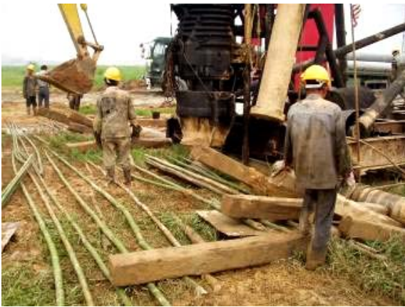
照片1 場地整理與打樁機定位
