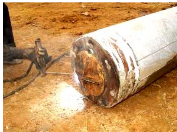
照片6 焊封底鈹(中空型PC樁)
