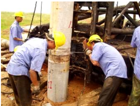
照片11 上下樁焊接
