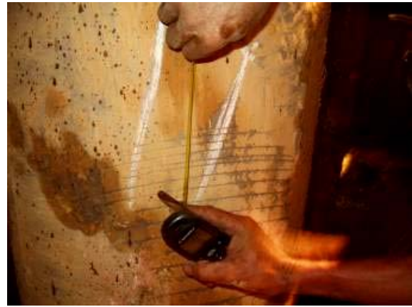
照片14 終止打擊刻劃量測每錘貫入量
