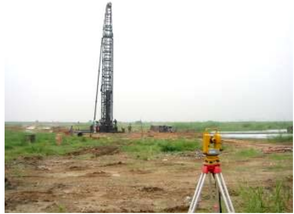
照片8 水準儀檢測PC樁垂直度
