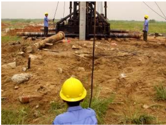
照片9 鉛垂線監控PC樁垂直度
