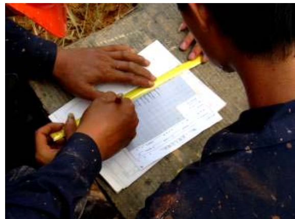
照片16 終止打擊反彈曲線檢核
