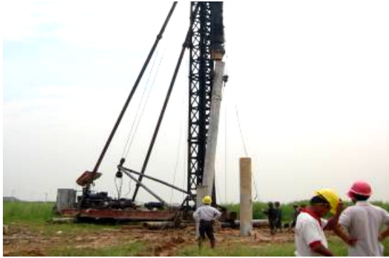
照片7 PC樁吊起
