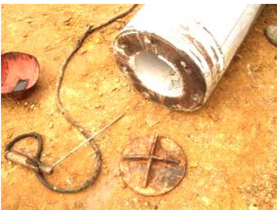
照片5 中空樁底封鈹
