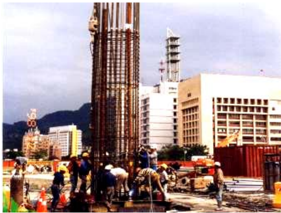
照片9 吊放鋼筋籠
