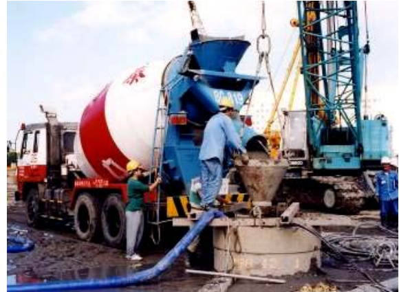
照片14 混凝土澆置
