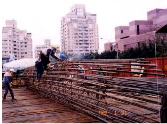
照片8 鋼筋籠製作
