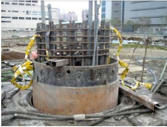
照片7 鋼筋籠臨時固定
