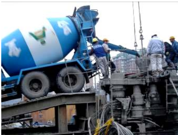
照片15 混凝土澆灌
