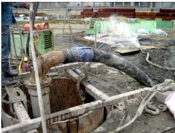
照片9 第二次孔底沉泥清除(Air-lift)
