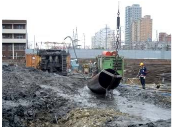
照片4 取土筒清除孔底沉泥
