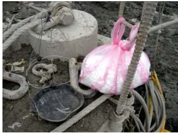
照片14 混凝土分隔器(保麗龍屑與皮碗)放置
