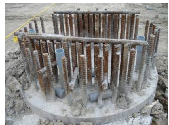
照片18 混凝土澆灌完成後樁頂狀況(無空打段)
