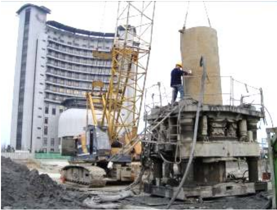
照片1 套管裝設(全迴式套管機)
