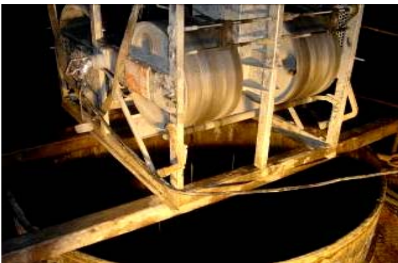
照片5 孔壁垂直度檢測
