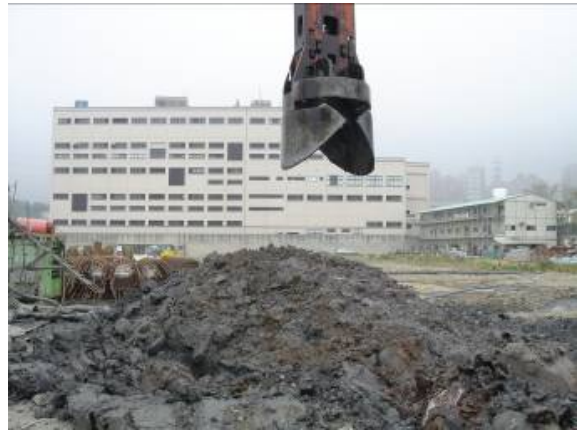
照片2 鑽孔掘削抓斗取土
