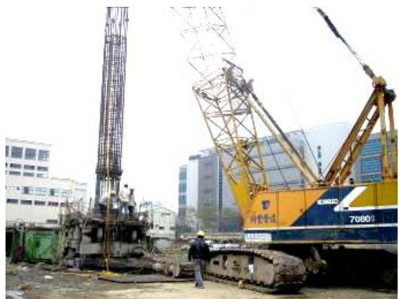
照片6 鋼筋籠吊放
