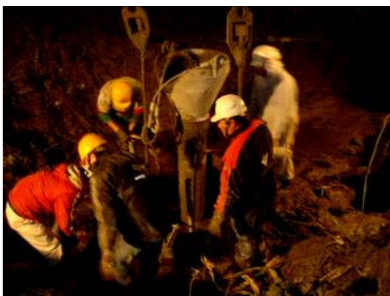
照片17 樁頂劣質混凝土排除(無空打段)
