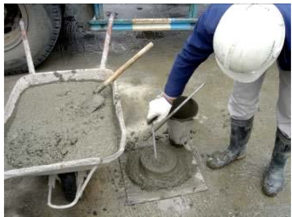
照片12 混凝土坍度檢測
