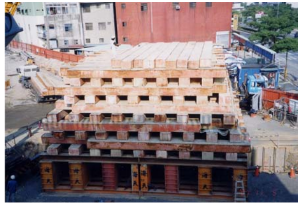
照片8 混凝土呆重塊吊裝三
