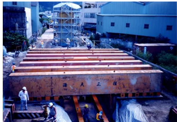
照片4 主副樑安裝
