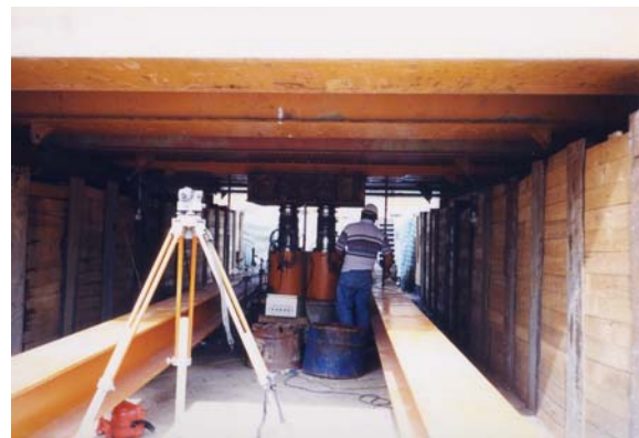
照片10 水準儀設置(檢測參考樑與試驗樁位移)
