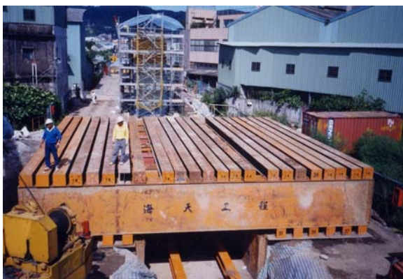
照片5 上層支撐樑安裝
