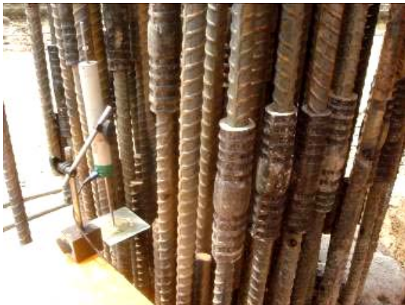
照片9 錨樁頂裝設變位計
