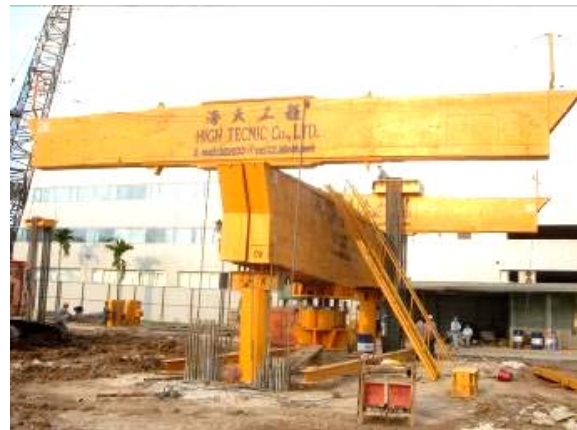
照片4 試驗鋼梁吊裝
