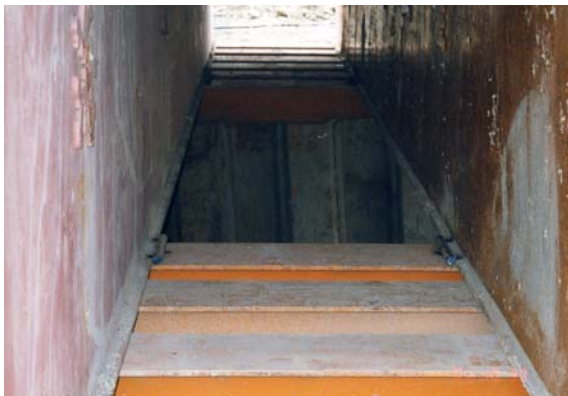
照片11 鋼樑臨時固定(焊接)
