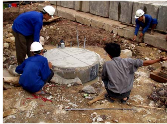
照片2 樁頂承壓中心點定位
