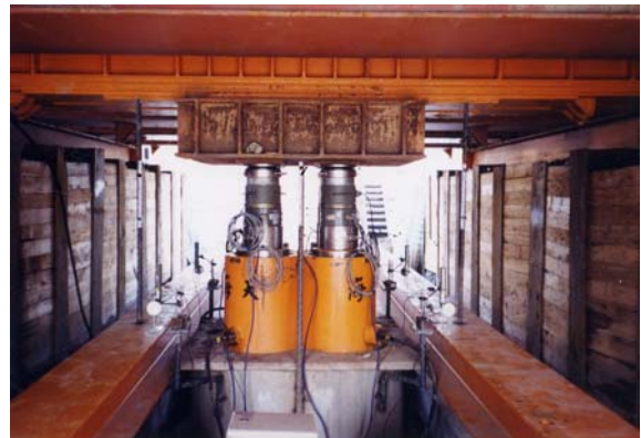
照片12 樁頭監測儀器安裝
