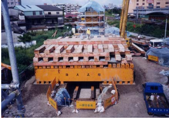
照片7 混凝土呆重塊吊裝二
