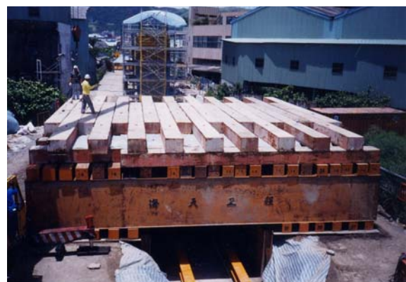
照片6 混凝土呆重塊吊裝一
